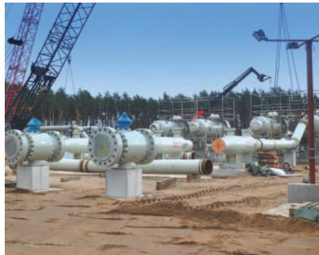
Zwei artec AIS-Regelkugelhähne, Typ RKH-HV, DN 600-500-600 werden in der Anladestation der Nord Stream-Pipeline, Anlagenbereich Offshore 1 – Druckreduzierstation, montiert.
