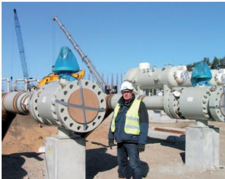
Der verantwortliche Bauleiter der Wingas Transport GmbH, Klaus Reisinger, vor zwei artec-AIS-Regelkugelhähnen DN 400, class 1500 HV, vorbereitet für die Montage der Schraubverbindungen und der elektro-hydraulischen Antriebe.
