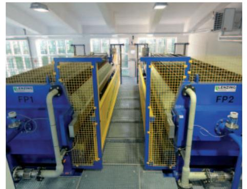
Statt der drei zerstörten Kammerfilterpressen wurden zwei leistungsfähigere Modelle installiert
