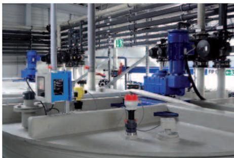
PH-Sonde, Füllstandsmesser und Überfüllsicherung (rot) auf einem der Behandlungsbehälter. Rechts der Getriebemotor.
