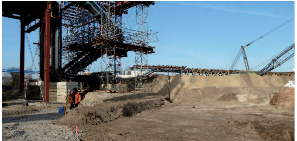
Einmessung der Schlitzwandaushubachse
