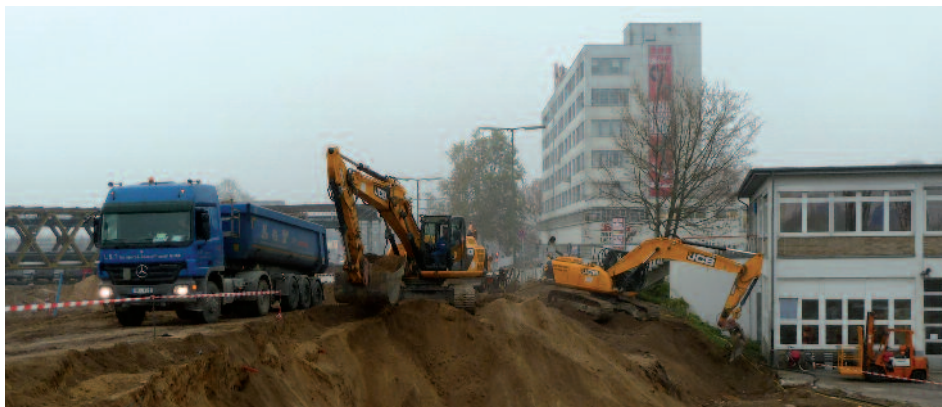
Trockenaushub im späteren Baudock 2
