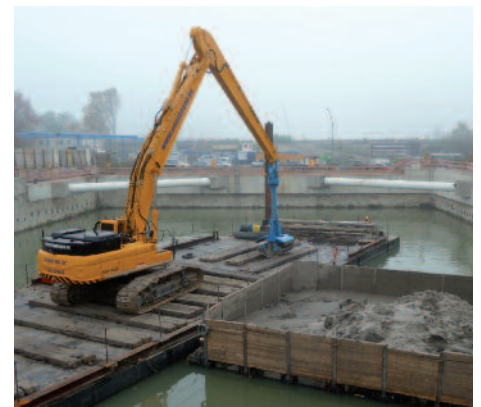
Nassauschub im Baudock 1.2
