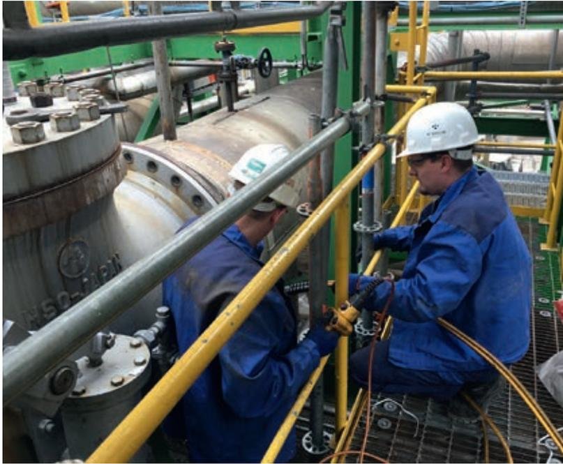
Im Rahmen des sogenannten „kleinen Stillstands 2016“ bei der PCK Raffinerie GmbH in Schwedt/Oder hat die artec AIS Armaturen und Industrieservice GmbH kürzlich die Revision von Rückschlagklappen und Einspritzkühlern sowie eines Regelkugelhahns und einer Treibdampfdüse durchgeführt. Unter anderem wurde in Schwedt das Katalysatorsystem FCC (Fluid Catalyst Cracking) turnusmäßig gewartet, wobei artec AIS die Instandsetzung von acht Armaturen übernahm.
