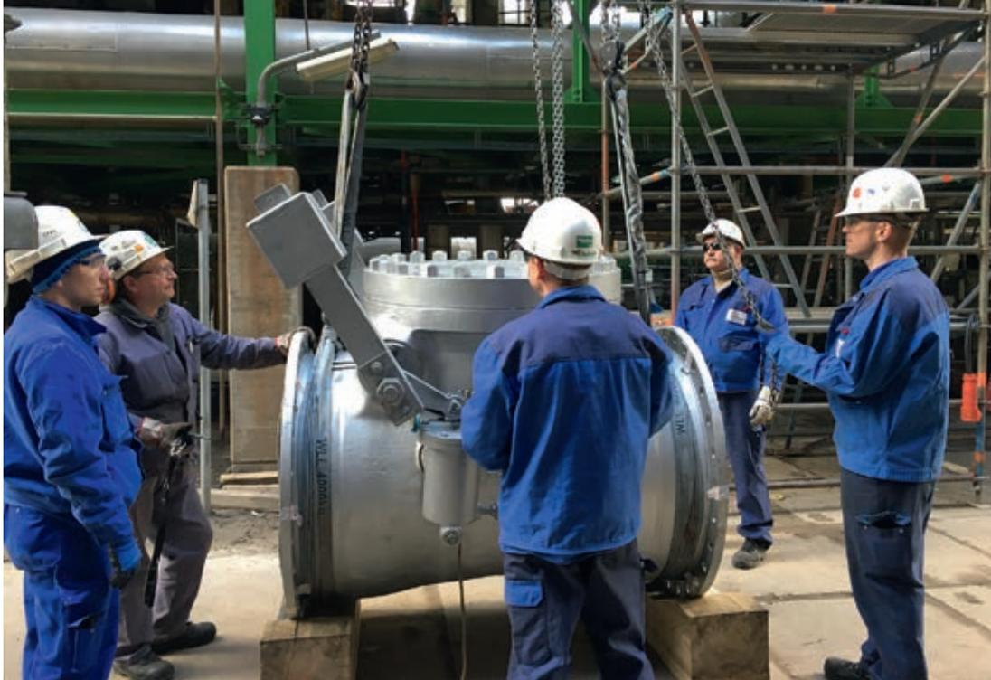
Nach der Revision durch artec AIS ist die Rückschlagklappe wie neu und bereit für die Remontage
