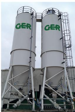
Die Aschen und Stäube werden mit Silofahrzeugen angeliefert und pneumatisch über Förderleitungen in die beiden Silos mit je 50 m<sup>3</sup> Fassungsvermögen befördert bzw. eingeblasen.
