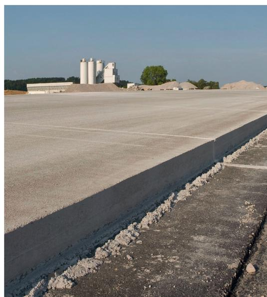
Sieht fertig aus, ist es aber nicht: Die Betondecke erfordert lange Abbindezeiten; Fugenverfüllung, Leitplanken und Fahrbahnmarkierungen fehlen noch.
