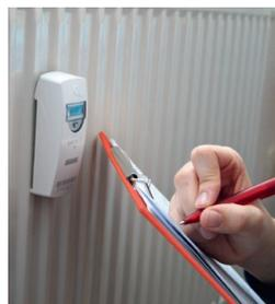
Dieses Bild soll nach der europäischen Energieeffizienz-Richtlinie spätestens ab 2027 der Vergangenheit angehören. Dann müssen Messeinrichtungen wie Heizkostenverteiler fernauslesbar sein.
