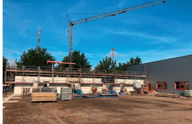
Neben der erst fünf Jahre alten zweiten Halle der atech (rechts) entsteht die neue. Derzeit sind die Büro- und Sozialräume im Bau, die Fundamente für die Stahlkonstruktion der Halle sind vorbereitet.
