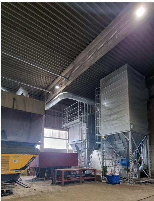
In der Mitte die neue Entstaubungsanlage für die Halle mit der Bodenwaschanlage, rechts davon die separate Entstaubung für den Brecher (links im Bild).
