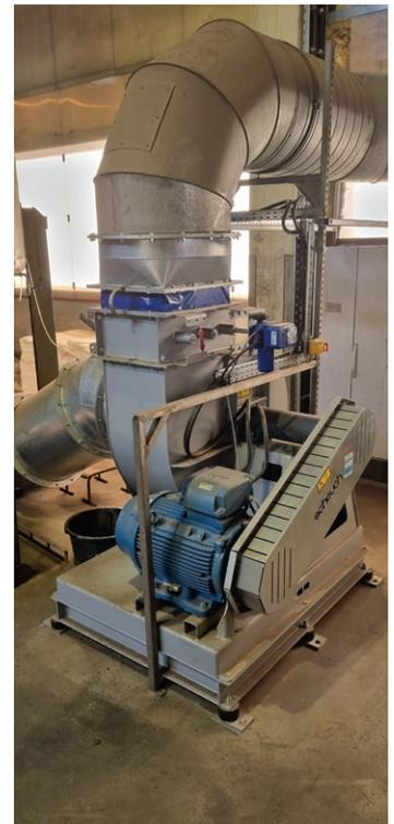
Das gesamte Abluftsystem wird durch einen Ventilator betrieben, der hinter den Aktivkohlefiltern für den nötigen Unterdruck im System sorgt
