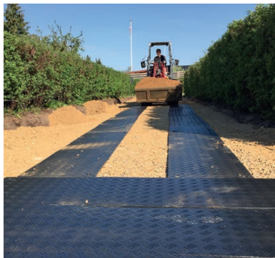
Die widerstandsfähigen, rutschfesten Strukturplatten der Danrec eignen sich unter anderem als temporäre Fahrstraßen
