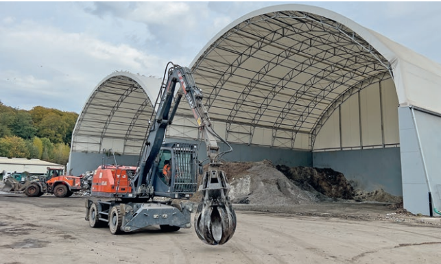
Die zweite Bogendachhalle bietet großzügige Lager- und Behandlungsflächen
