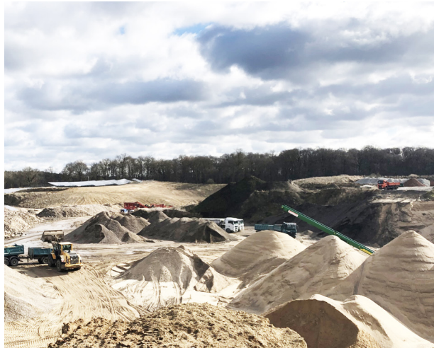
Blick auf das Gelände der Mineralik Friedland GmbH & Co. KG in Ramelow: Oben rechts im Bild der verlegte und erweiterte Recyclingplatz; auf dem Bereich rechts daneben (nicht im Bild), wo sich der „alte“ Recyclingplatz befand, werden jetzt ebenfalls Sand und Kies abgebaut.
